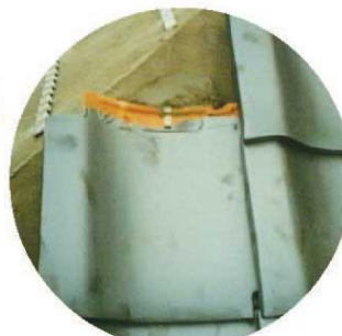
防災安定瓦條 (防風抗震，使瓦不脫落、不爆裂) 多國專利肯定(適用各型瓦)
